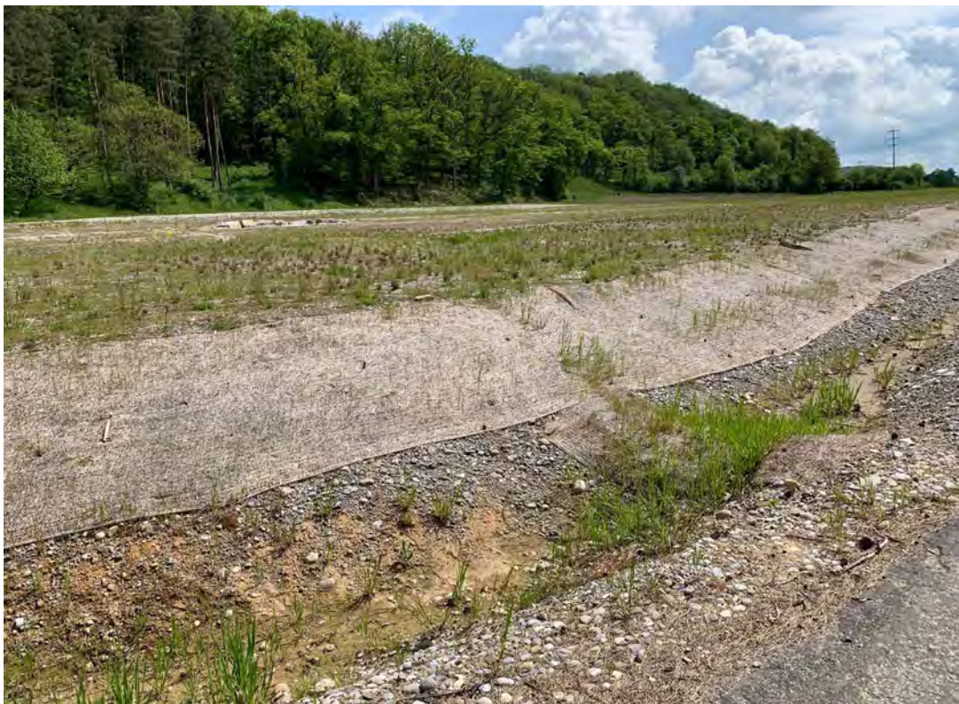
Abhumusierte Fläche, aufgefüllt mit Kies
